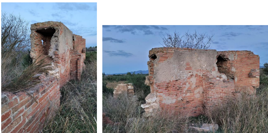
Mur de prova de les metralladores
